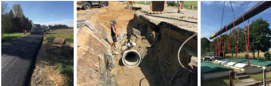
Alles neu: Straßenbau, Kanalbau, Reparaturen in der Kläranlage
